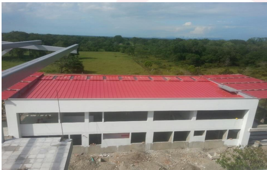
Foto 2: vista Superior edificio Administrativo (Foto mayo 2017)
