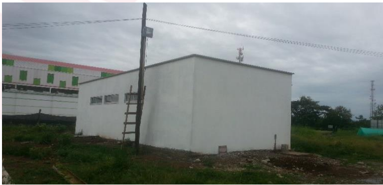
Foto 6: isometría cuarto de máquinas. (Foto mayo 2017)
