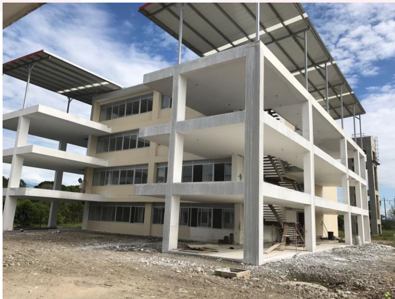
Foto 3: Edificio Aulas vista isométrica. (Foto agosto 2017)
