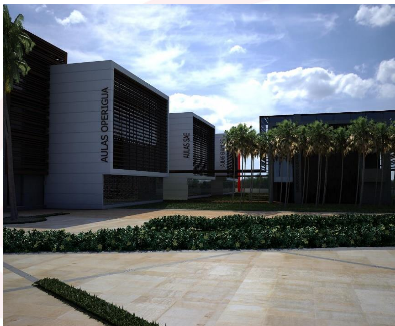
Foto 9: zona edificio Aulas (Edificio construido Actualmente es el central).
