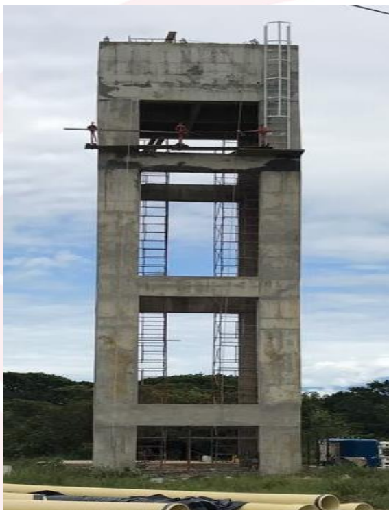
Foto 7: tanque elevado. (Foto agosto 2017)
