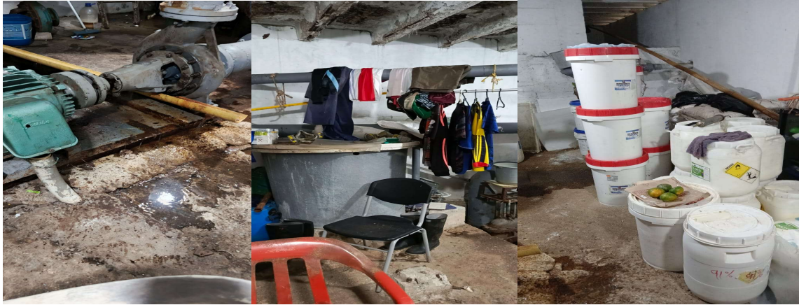
Planta de tratamiento de agua potable PETAP y de aguas residuales PETAR
